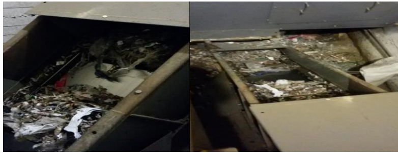
Рис. 1 Подача палива транспортером із бункера до котла
