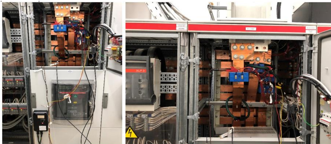
Рис. 1. Схема під'єднання аналізатора якості Circutor CIR-E3 AUDITOR на вводі у РП 0,4 кВ
