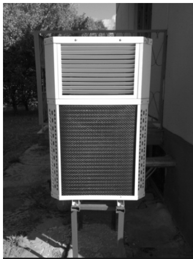
Рис. 1. Тепловой насос «воздух – вода» типа THDTR600/R
