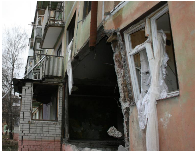
Рис. 2. Відхилення від проектного положення і обвалення тришарових стінових панелей і плит перекриттів в панельному будинку серії 1-464 А.
