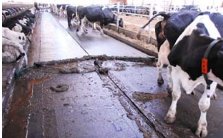
Рис. 1. Гладка бетонна поверхня гнойового каналу.
